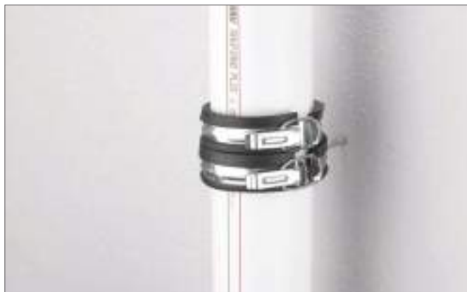
Рис. 8-3 Шумопоглощающий хомут в смонтированном состоянии
